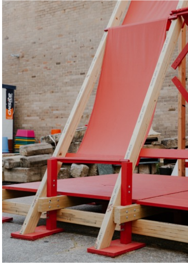
FIG 09. Detalle de apoyo del pabellón / Detail of the pavilion's footings [Fotografía / Photography Hamish McIntosh].
