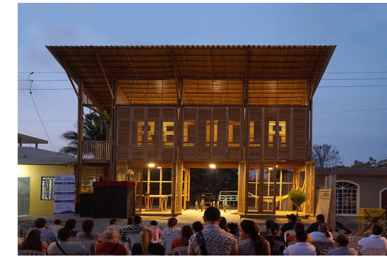
FIG 04. La Comuna (Espacio Productivo + Vivienda Adaptable). Natura Futura Arquitectura + Frontera Sur Arquitectura. Huaquillas, El Oro, Ecuador. 2018. Fuente: Natura Futura https://naturafuturarq.com/proyecto/la-comuna / La Comuna (Productive Space + Adaptable Housing). Natura Futura Arquitectura + Frontera Sur Arquitectura. Huaquillas, El Oro, Ecuador. 2018. Fuente: Natura Futura https://naturafuturarq.com/proyecto/la-comuna
