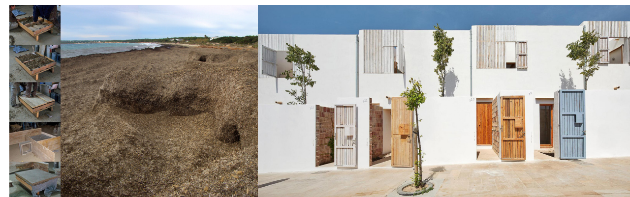
FIG 05. Fabricación de aislamiento térmico a partir de la posidonia para la construcción de 14 viviendas sociales en Sant Ferran. Formentera. 2017. Fuente: Proyecto Life Rehousing Posidonia http://reusingposidonia.com/posidonia/ / Manufacturing of thermal insulation from Posidonia for the construction of 14 social housing units in Sant Ferran. Formentera. 2017. Fuente: Proyecto Life Rehousing Posidonia http://reusingposidonia.com/posidonia/
