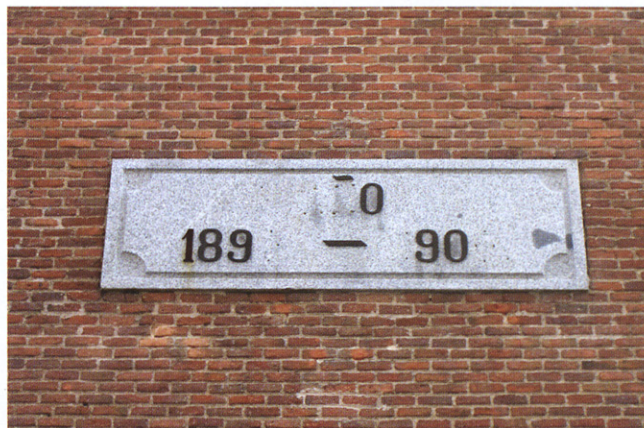
i1 La placa de granito sobre la clave del arco del antiguo portón del número 27 de la calle Almadén.
