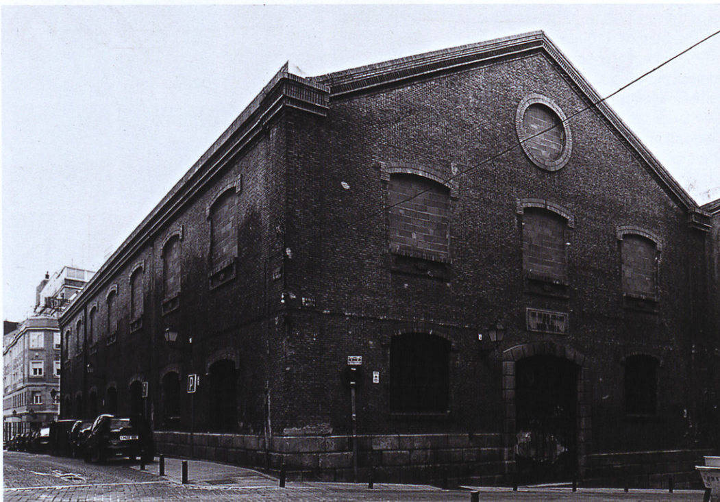
i2 Antigua Central Eléctrica de Mediodía, la esquina de las calles Almadén y Cenícero.
