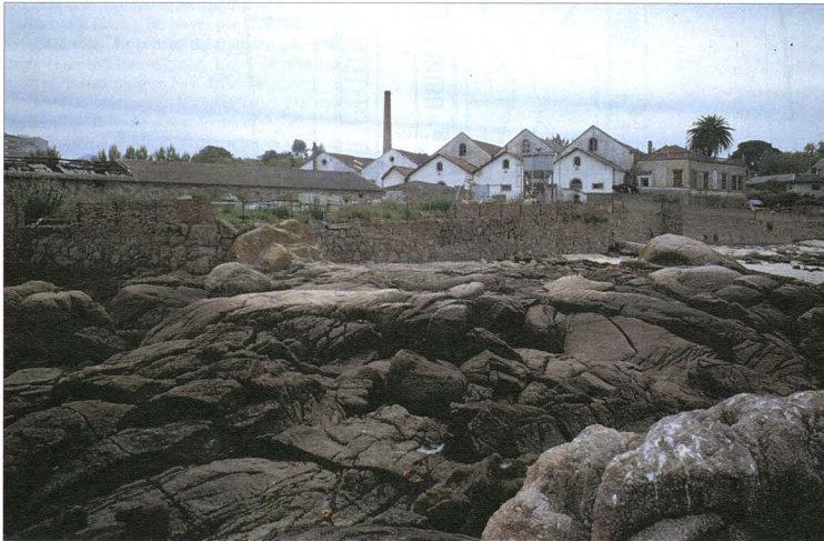
Vista del conjunto de naves a rehabilitar para ubicar el museo.
