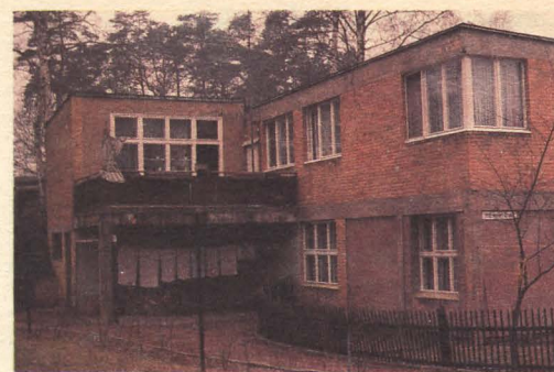
Vista trasera de las viviendas de los profesores. Rear view of the teachers' residences. Foto: Arturo López-Bachiller.
