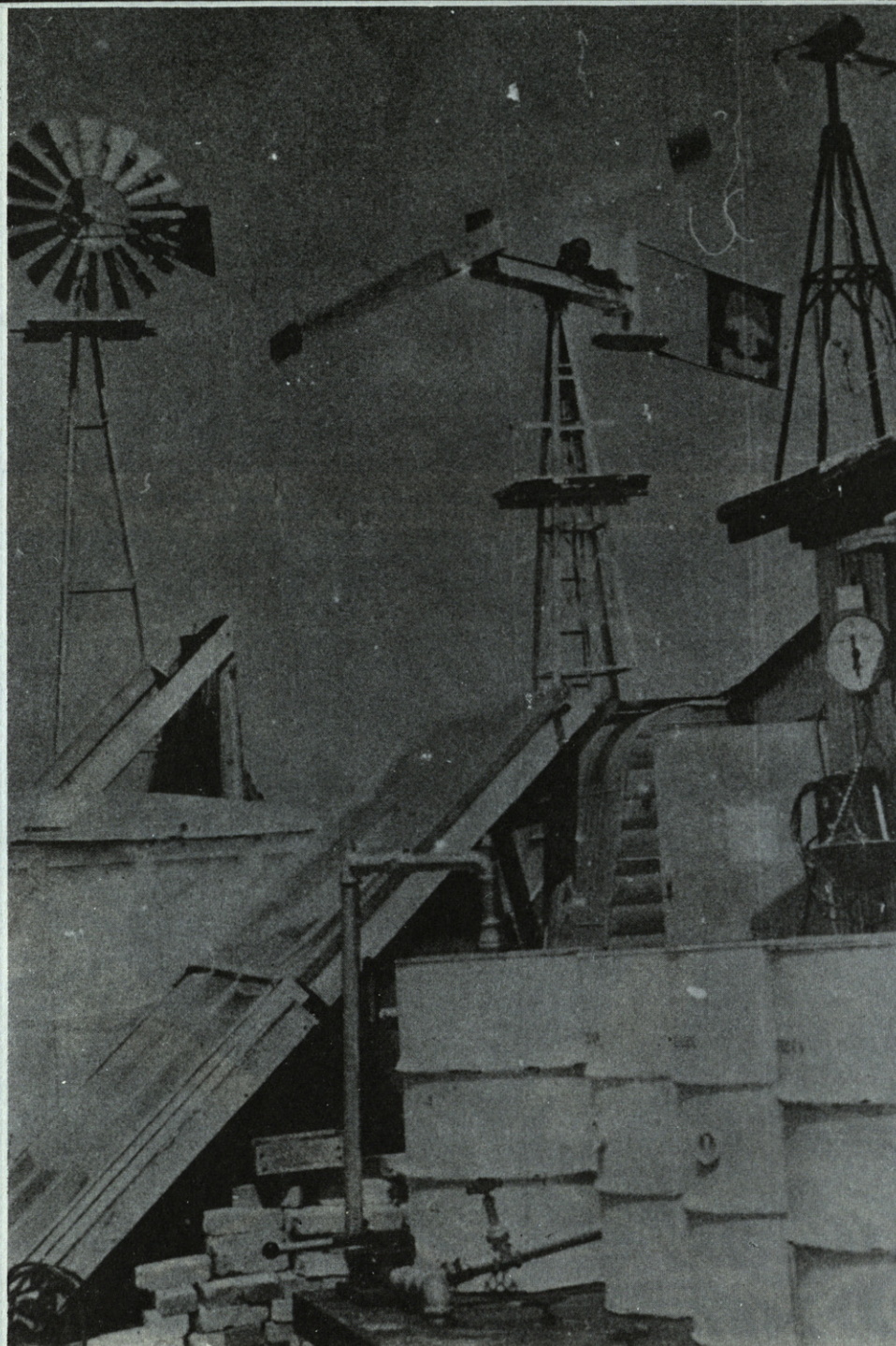
En el Max's Pot de Austin, Texas, generadores eólicos y colectores solares coexisten con los bidones de una planta generadora de gas obtenido por la descomposición de materia orgánica.
