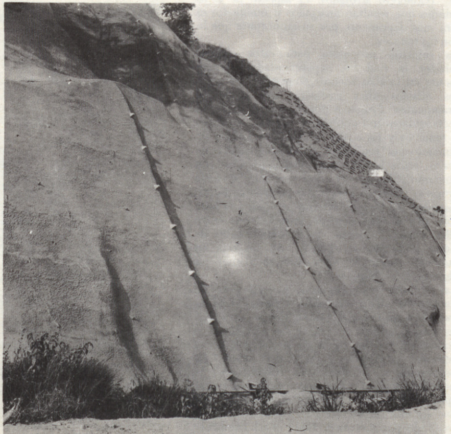
Jardineras rampantes sobre taludes de hormigón. Alzado desarrollado, perspectiva de las jardineras y vista de los taludes. La plantación se hace con especies diversas de aloes, bromelias, euphorbias, agaves, Bhryophillum , sansevierias , opuntias, pedicularis , cereus , sedum , etc.
