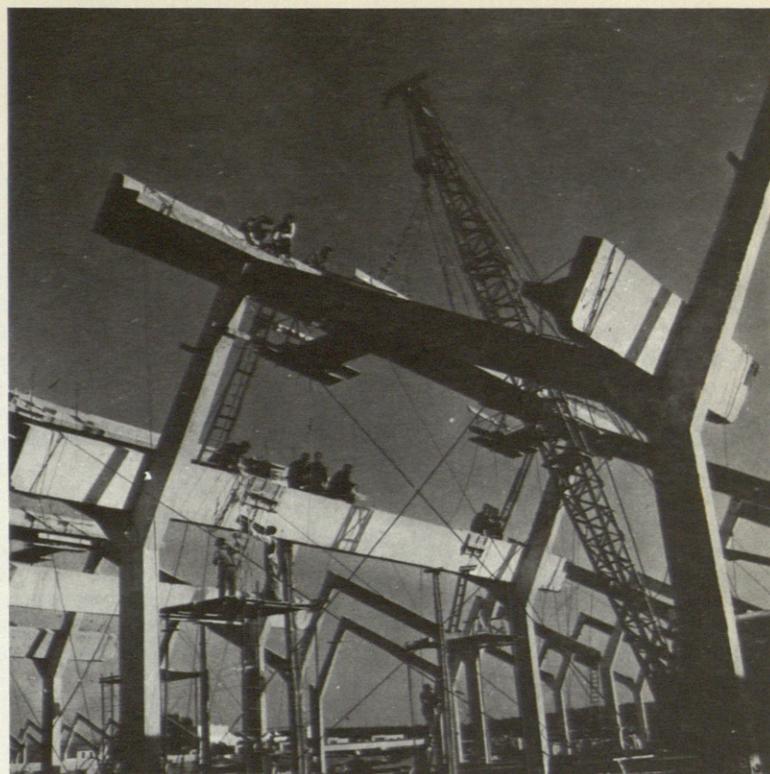
Montaje de prefabricado total en Metalúrgica Santana, Madrid.
