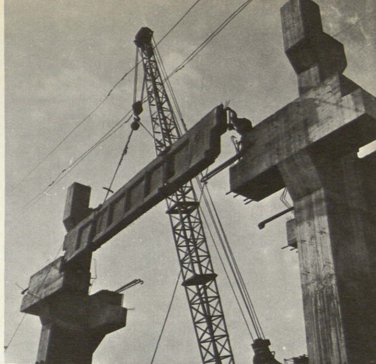
Montaje de vigas de puente grúa en ENSIDESA
