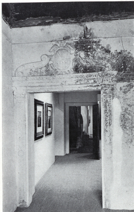
Al hacer las obras de adaptación aparecieron elementos arqueológicos, que se han conservado.
