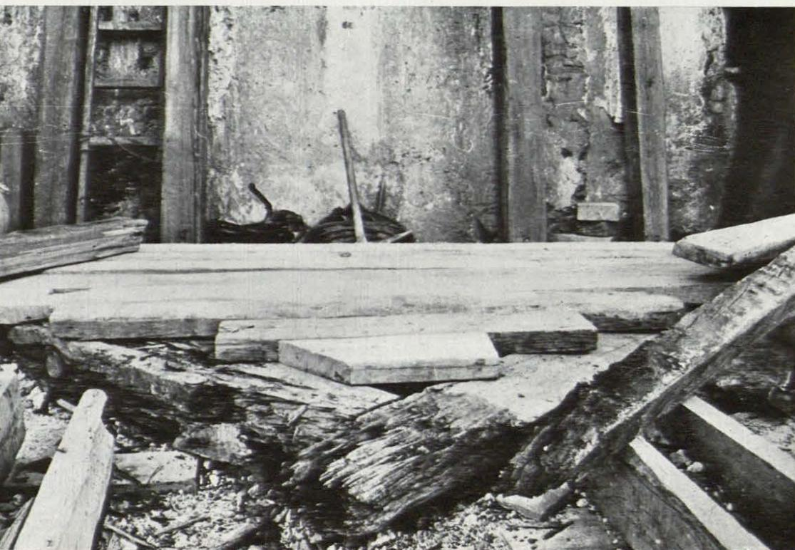
Lucerna del Colegio. Sus dañadas estructuras leñosas, completamente en ruinas, se han desmontado. La nueva estructura metálica se ha dibujado según las trazas de Herrera para formar unas esbeltas pirámides octogonales que arrancan de cuatro lados (cuerpos de torre).
