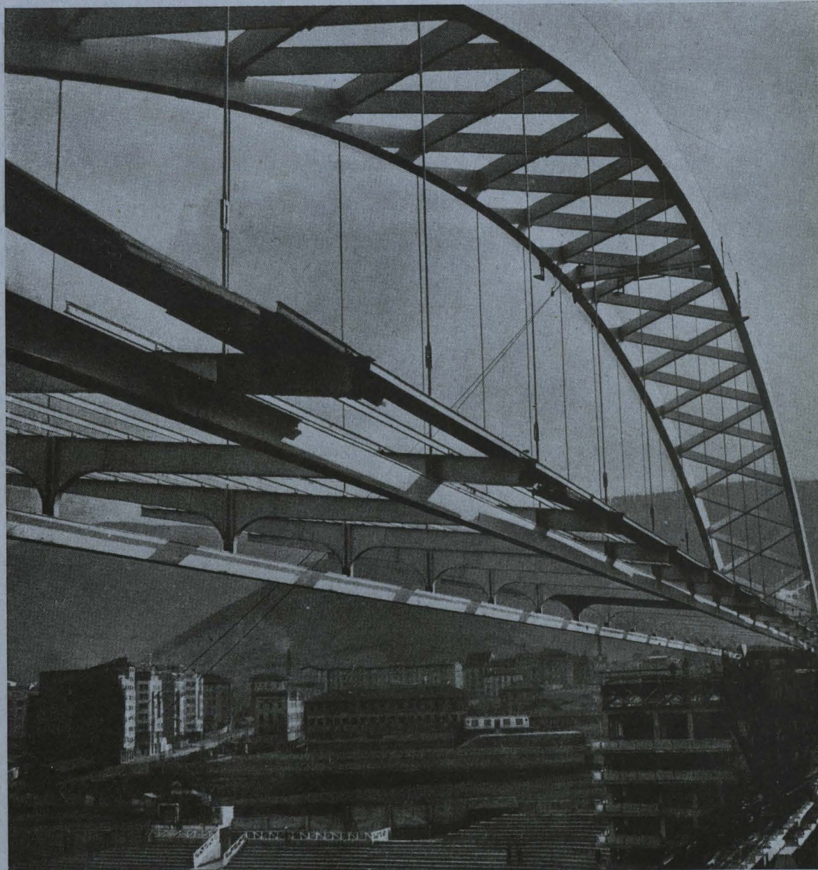
Estructura metálica soldada de la cubierta para la tribuna de San Mamés.
