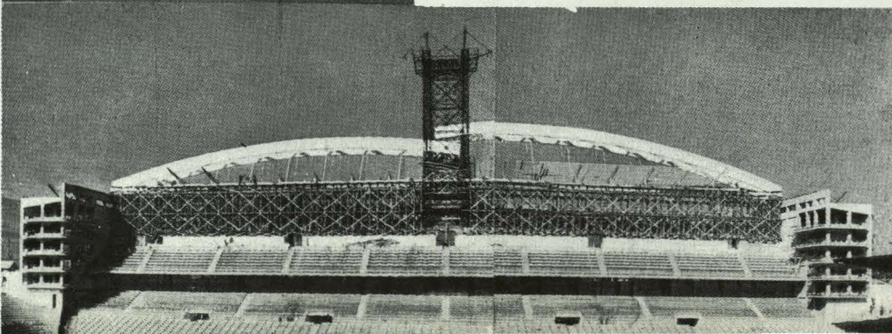
Diferentes fases de la construcción de la tribuna. Fué necesario hacer la obra sin interrumpir los partidos, aprovechando los meses de descanso del verano para demoler la tribuna antigua.
