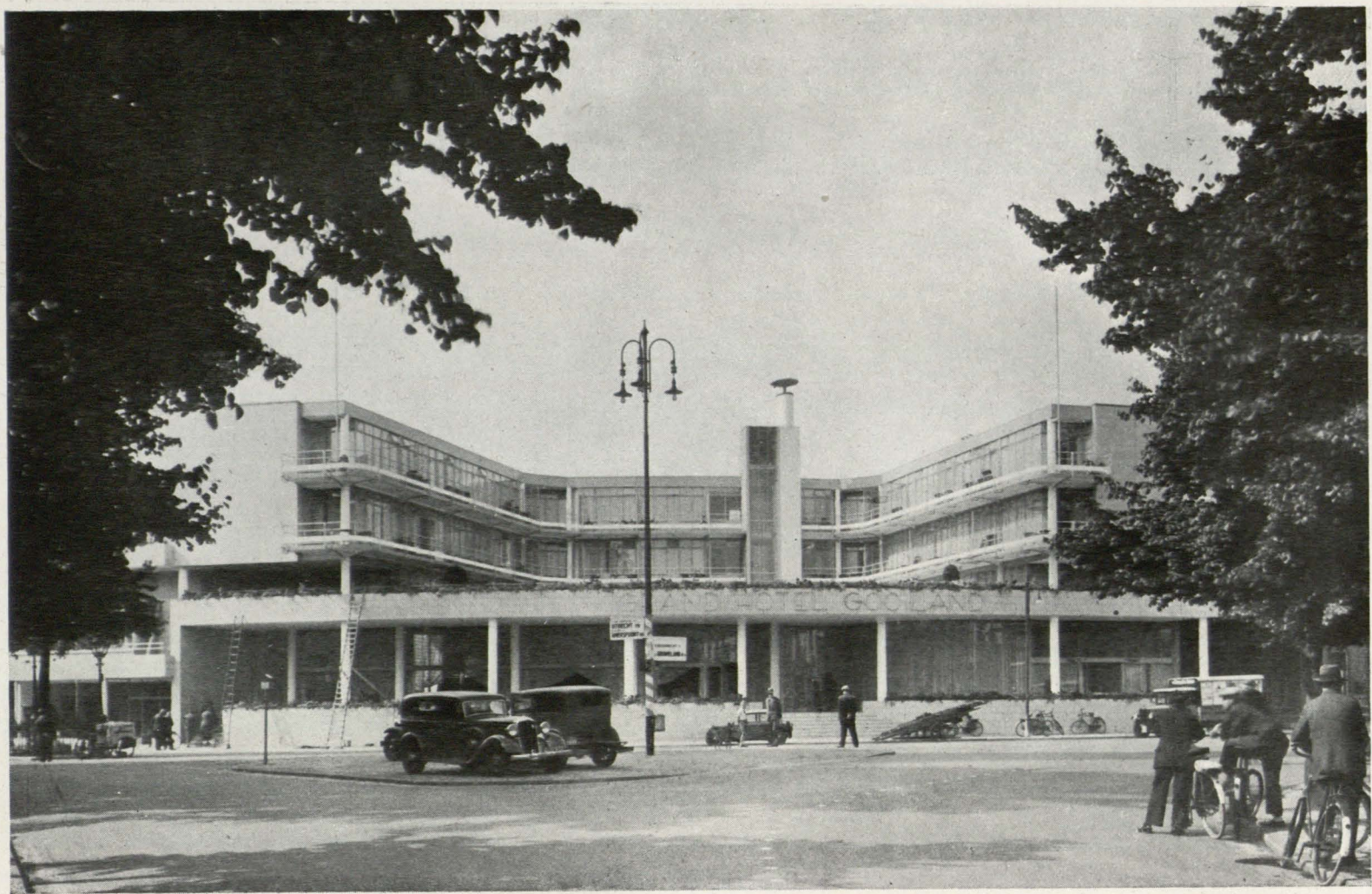
El «Grand Hotel Gooiland», de Hilversum, del arquitecto Duiker, un ejemplo de las posibilidades del tipo «esqueleto».
