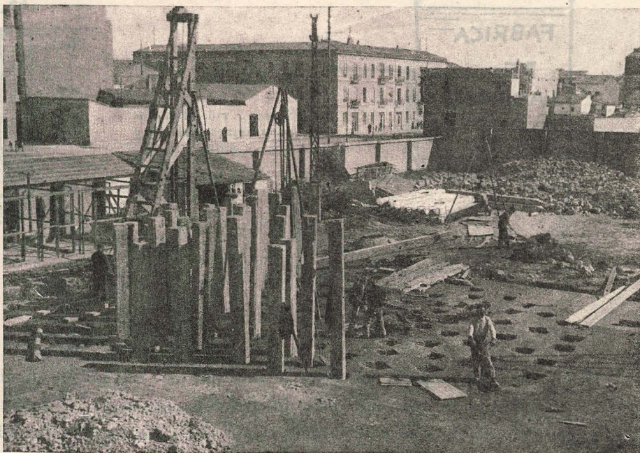
Figuras 4, 5 y 6. Distintos momentos del hincado de los pilotes.
