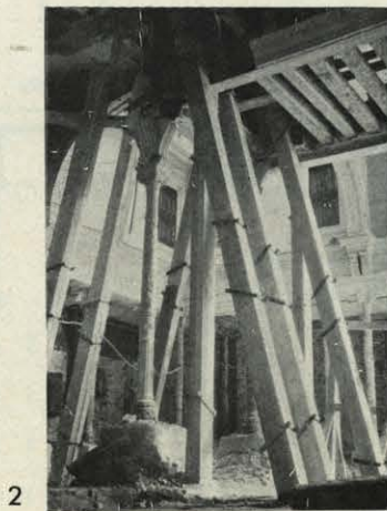
1 a 6: El bosque de columnas de fundición va siendo sustituido por el de apeos,
