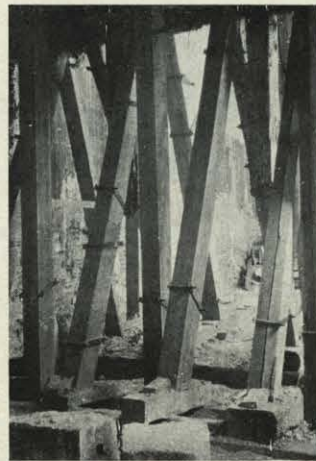
1 a 6: El bosque de columnas de fundición va siendo sustituido por el de apeos,
