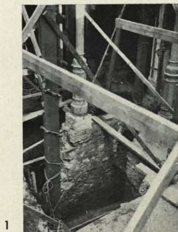
1 a 6: El bosque de columnas de fundición va siendo sustituido por el de apeos,
