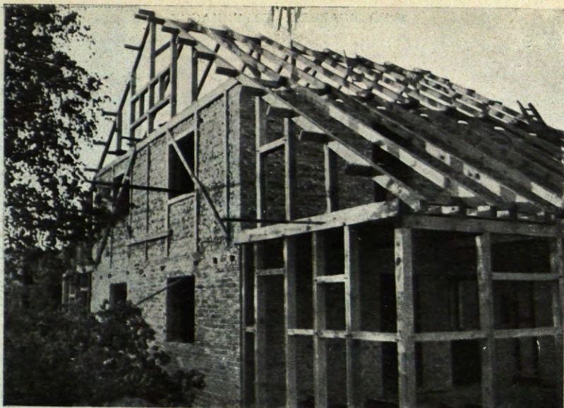
STADTRANSIEDLUNG (POTSDAM, 1933). LA PARTE DE VIVIENDA ES DE FABRICA DE LADRILLO; EL ESTABLO Y VESTIBULO SON DE ENTRAMADO DE MADERA
