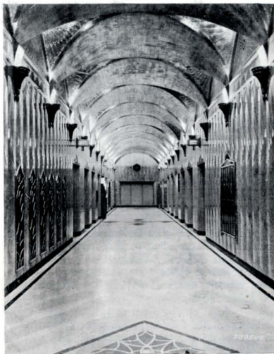
Iluminación indirecta mediante reflectores asimétricos. (Nótese la gran uniformidad de iluminación).
