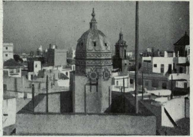
TORRE DE LA CASA NÚMERO 10 DE LA CALLE DE VALVERDE.
