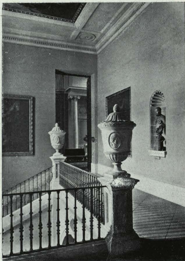
OTRO ASPECTO DE LA ESCALERA NUEVA.
