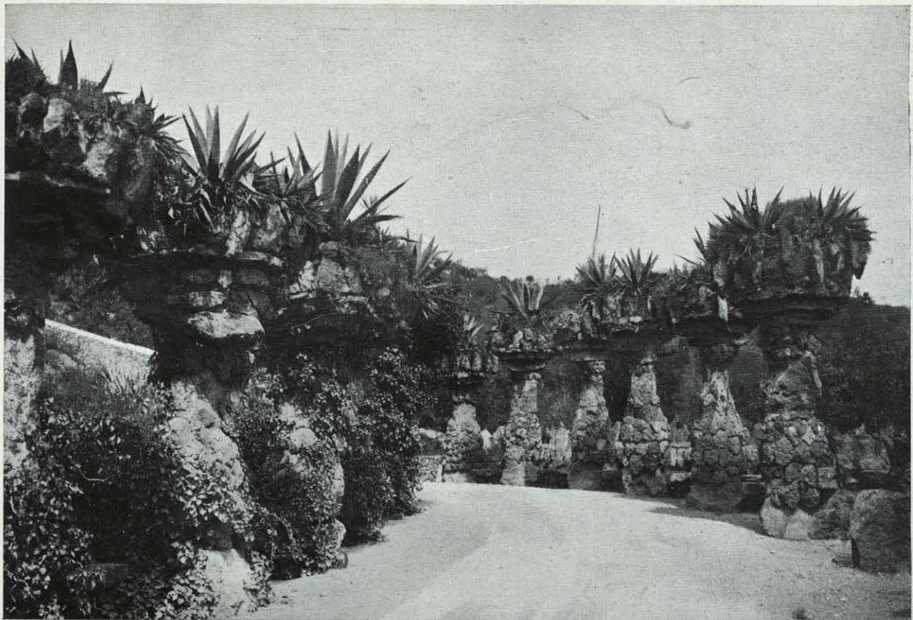
viaductos del Parque Güell, es un sistema que equivale al de viga y bovedilla puesto verticalmente y que viene a originar unas superficies curvas con sólo el grueso necesario para transmitir la presión a unos contrafuertes que hacen como de vigas verticales y que oponen la suficiente resistencia.
