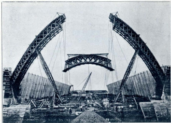
ELEVACIÓN DEL ELEMENTO CENTRAL DE LA CIMBRA.
