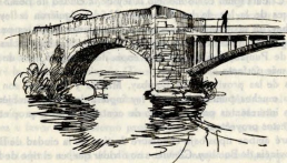
Puente sobre el río Besaya, en la provincia de Santander. — El tramo central del viejo puente se hundió y ha sido reconstruido con hormigón armado, sin pretensión alguna artística, y, sin embargo, es obra bellísima y artística.
